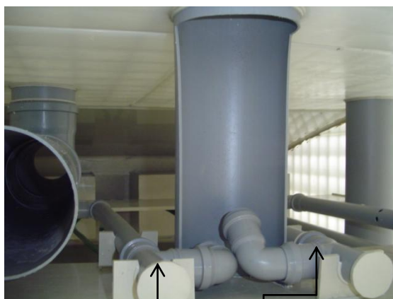
Mamut pumpe 1 i 2 teraju prečišćenu vodu iz uređaja
